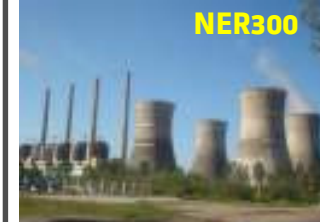
Getica - CET Turceni Roumanie - >250MWe Chilled ammonia - Lignite
